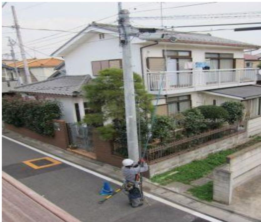
Slika 9 Primjer postavljanja svjetlovodnih kabela putem nadzemne mreže
