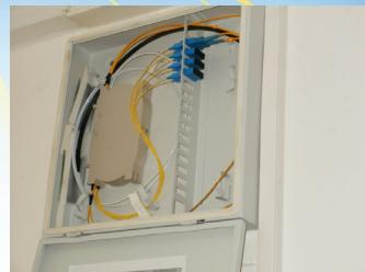
❹ podžbuknom postavom PVC cijevi. Nakon toga slijedi postavljanje svjetlovodnih instalacijskih kabela ili sustava mikro-cjevčica. Najskuplji način zbog građevinskih radova kopanja i saniranja kanala u koje se postavljaju podžbukne PVC cijevi, ali dugoročno i sigurno rješenje.
