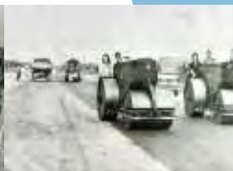
Valjanje asfaltnog zastora
